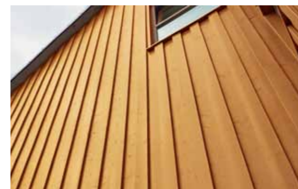
Die physikalisch trocknenden Bindemittel lagern sich an der Oberfläche ab und trocknen extrem schnell, während die chemisch trocknenden Bindemittel nachtrocknen. Dadurch ist Cetol BL XPro bereits nach 90 Minuten regenfest.
